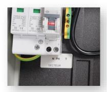
L'alimentation s'effectue en monophasé avec terre sur un disjoncteur 16A. Une protection parafoudre est intégré au coffret pour la partie secteur.
