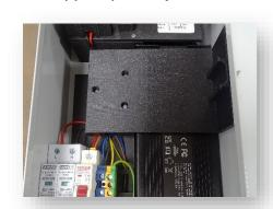
Un support est prévu pour placer un injecteur POE 4 sorties pour l'alimentation des caméras.
